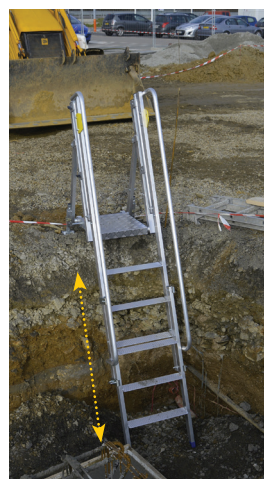
Piètements télescopiques réglables sur 4 hauteurs.
